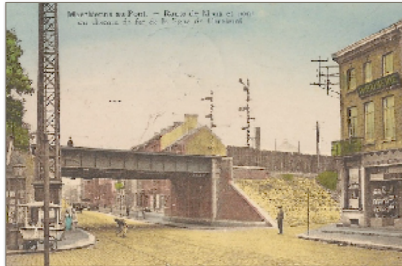
Marchienne-au-Pont, le pont du chemin de fer au-dessus de la route de Mons, http://charleroi-pays-noir.blogspot.be
